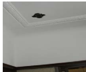
一階洋間の天井の四隅にクローバーのような形の穴?これは換気口です。進んでましたね。
