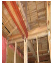
鉄骨で補強、壁には断熱材
