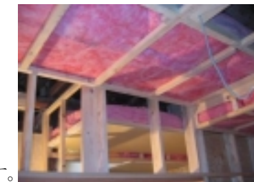
A：天井の断熱材
