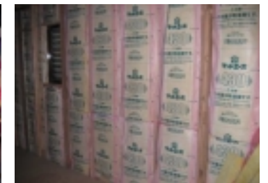
B：壁の断熱材
