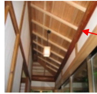
木小舞天井ときれいに磨かれた丸桁
