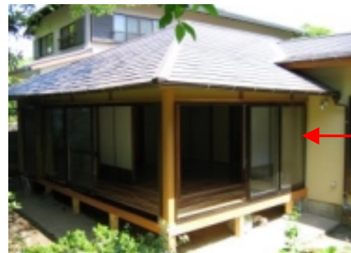
中庭から見た廊下と和室
