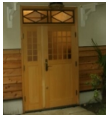
玄関ドアと外部 下見板
