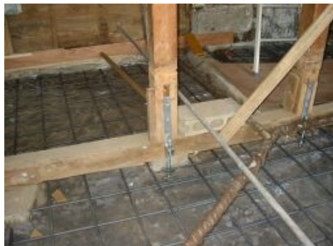
土間に防湿フィルムを敷き、鉄筋を組みました。ホールダウン金物も取り付けました。
